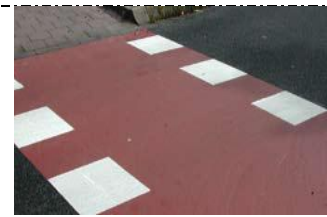
Hier een oversteekplaats met blokmarkering, om de aandacht te trekken heeft de wegbeheerder er een rode kleur aangegeven
