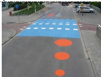
Hier een oversteekplaats met blokmarkering, de wegbeheerder heeft gekleurde stippen en een blauwe kleur op het wegdek aangebracht om de aandacht van de automobilist te trekken
